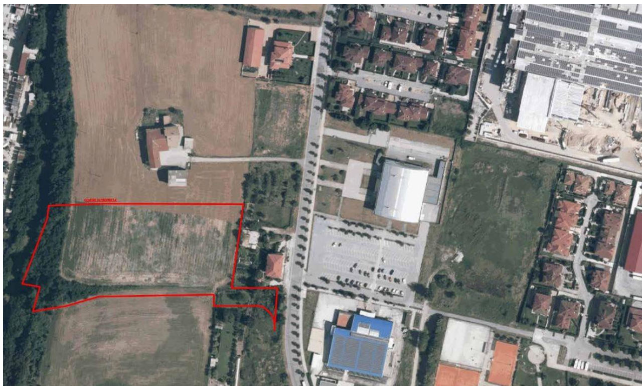
Vista aerea della futura area di cantiere
