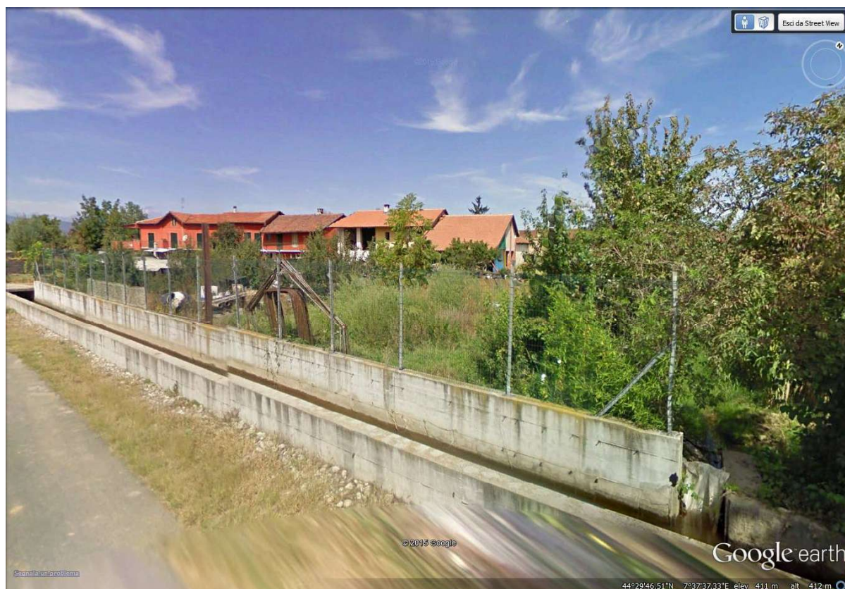
6 - Roata Topini, lungo la strada a sud
