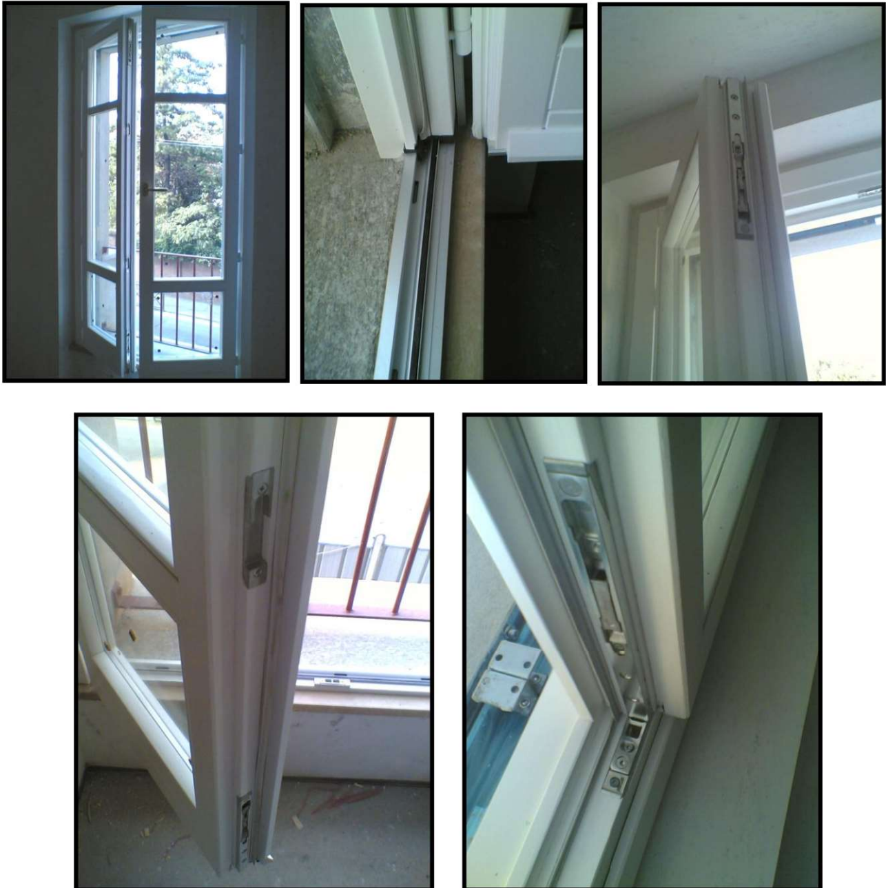
Figura 11 - serramento in legno lamellare con 6 punti di chiusura e 8 cerniere di tenuta
