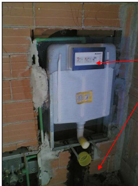
Figura 14 – modalità di posa ancoraggi tubazioni di scarico
