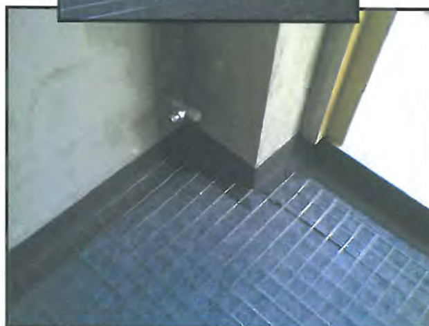
Figura 8 - posa del materiale in cantiere
