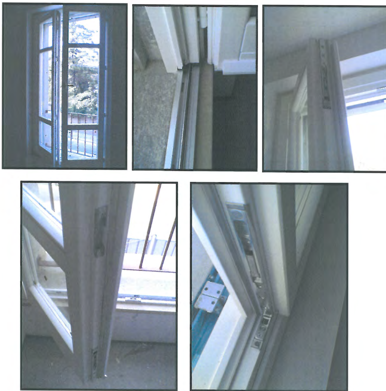
Figura 9 - serramento in legno lamellare con 6 punti di chiusura e 8 cerniere di tenuta
