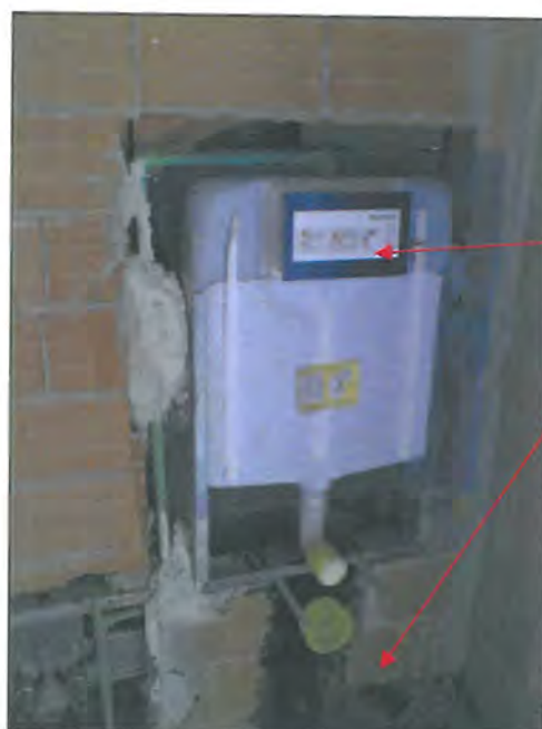
Figura 16 – modalità di posa ancoraggi tubazioni di scarico
