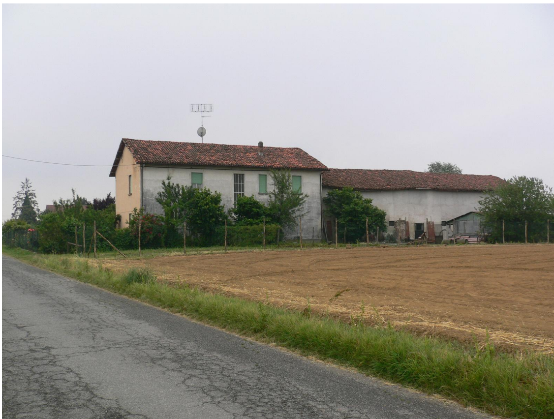
5: L'edificio residenziale a est del mappale 331
