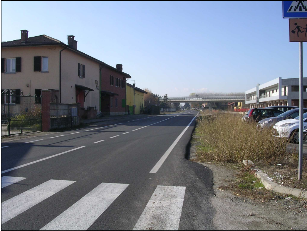
Veduta di Via Ceresolia in corrispondenza del punto in cui verrà ricavata la rotatoria di attestazione della nuova Dorsale che attraverserà tutto l'ambito del P.U.C.
