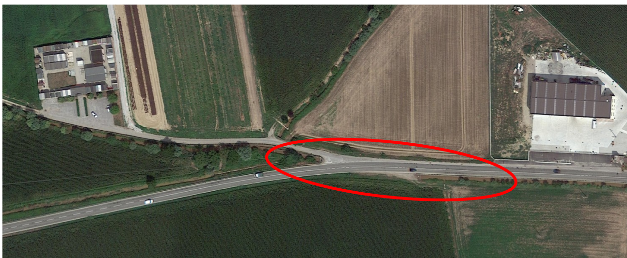
vista aerea dell'area interessata dal nuovo marciapiede
