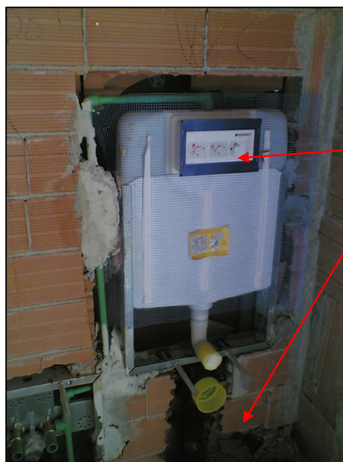
Figura 14 – modalità di posa ancoraggi tubazioni di scarico
