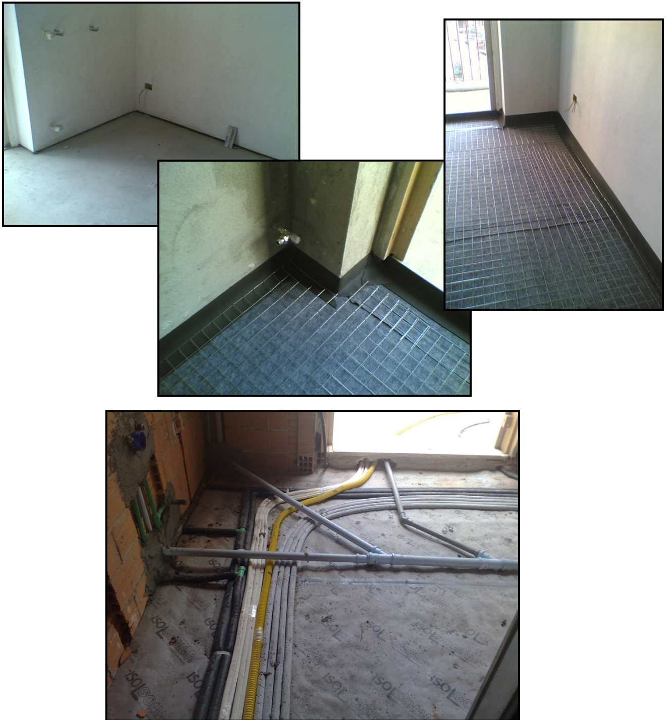
Figura 9 - posa del materiale in cantiere – sopra alleggerito e sotto alleggerito – in caso di posa di pannello radiante il materiale anticalpestio va posato sotto il pannello radiante qualora in progetto
