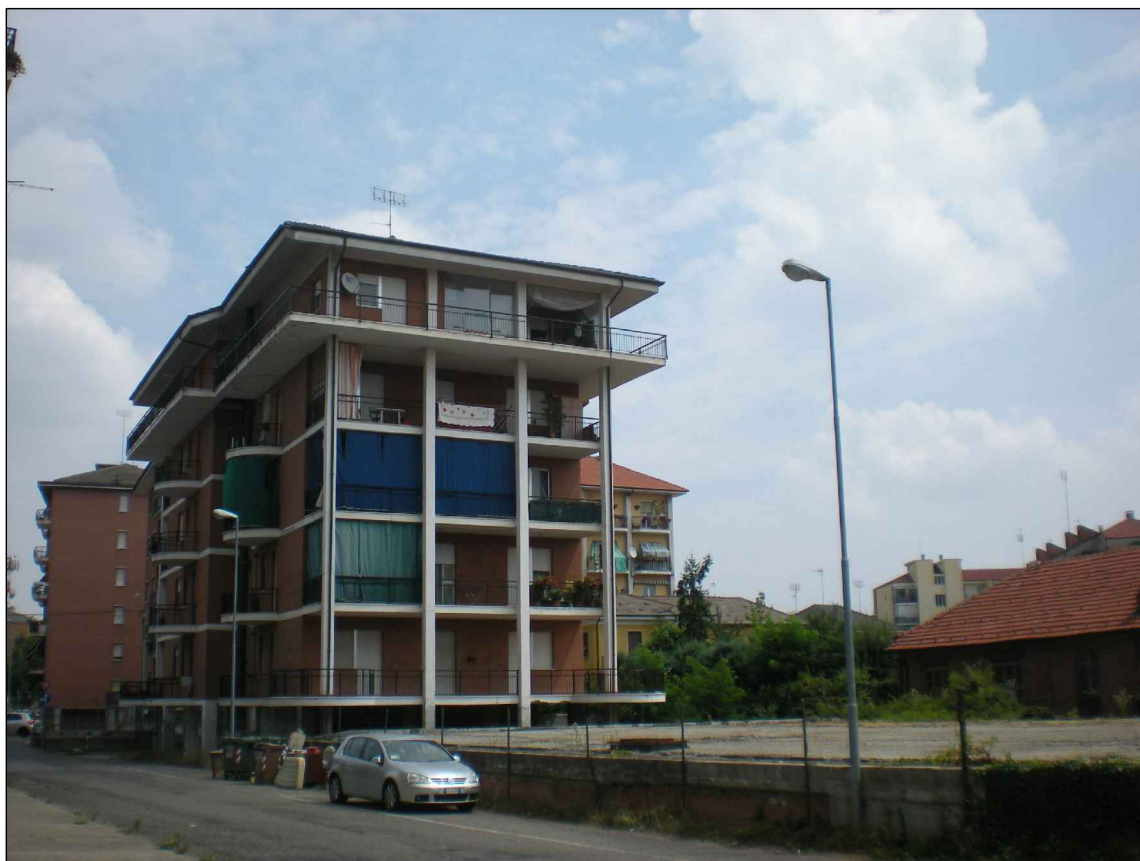
FOTO 1 - IL LOTTO DI INTERVENTO E IL CONDOMINIO ALEXANDRA VISTI DA SUD
