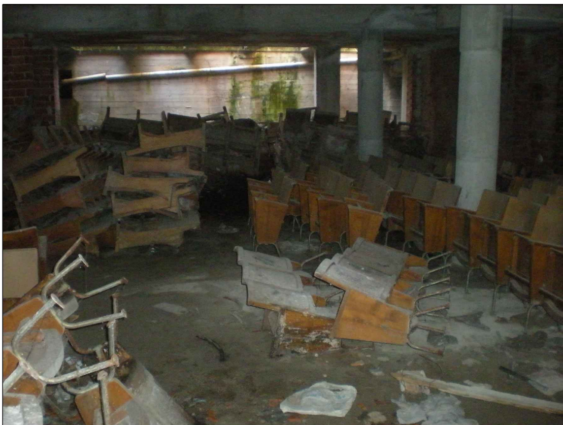
FOTO 16 - PARTICOLARE DELL'ATRIO INTERRATO
