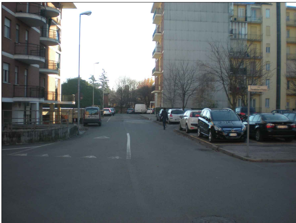
FOTO 3 - IL TRATTO DI VIA NOVARA OGGETTO DI INTERVENTO VISTO DALL'INCROCIO CON VIA ALBA
