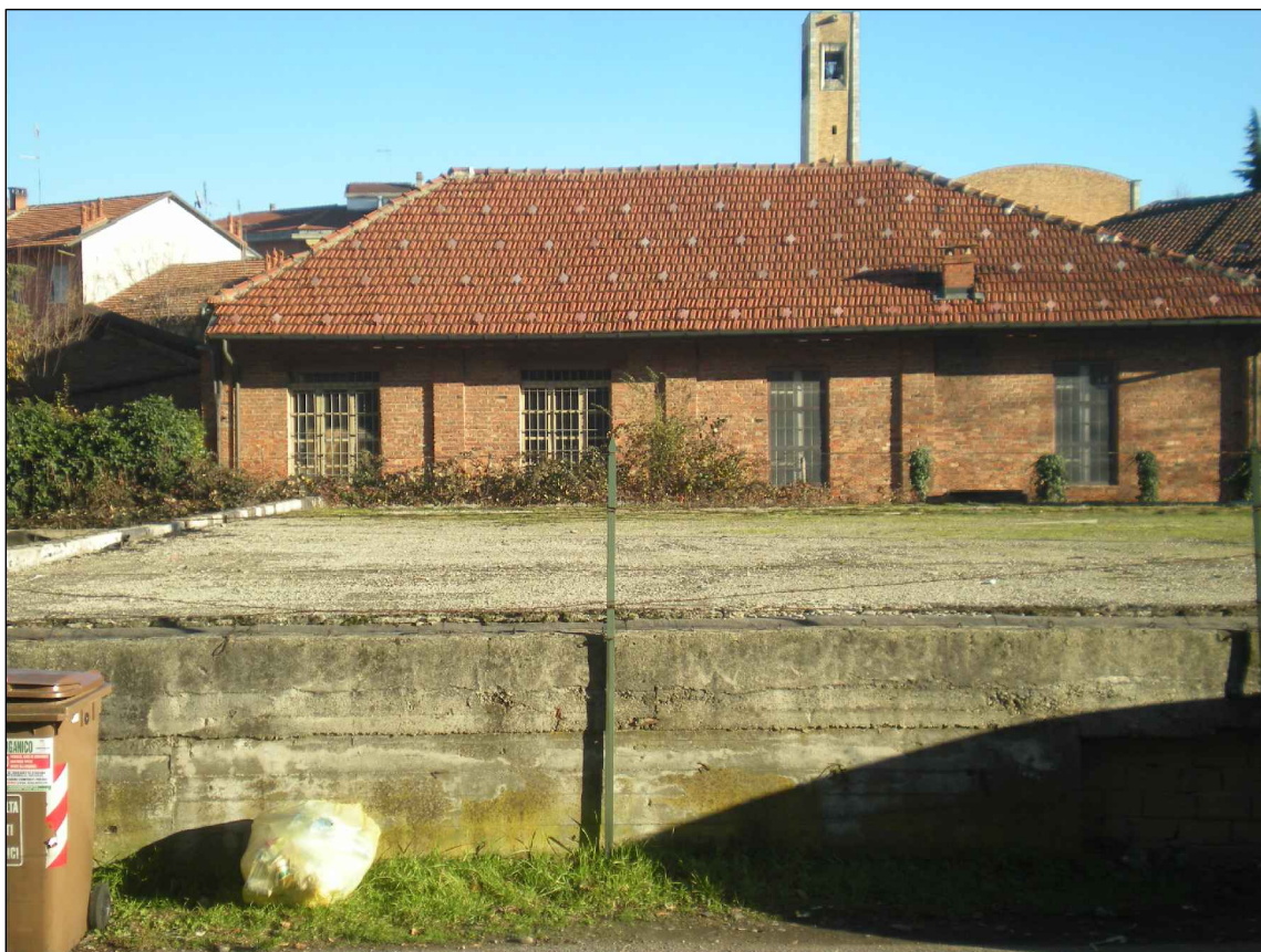
FOTO 10 - IL FABBRICATO ACCESSORIO SUL CONFINE EST
