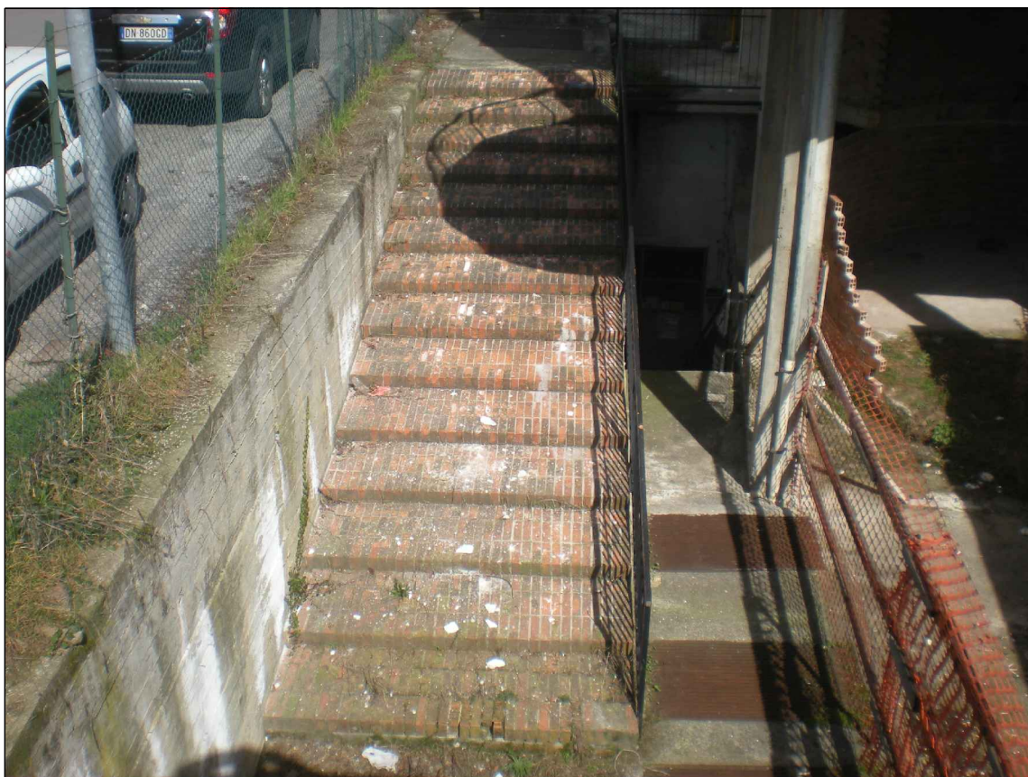
FOTO 18 - PARTICOLARE DELLA VIA DI FUGA ESTERNA
