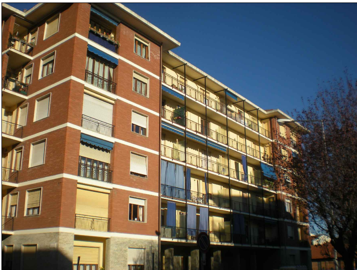
FOTO 8 - IL CONDOMINIO "EDERA" POSTO A OVEST DEL LOTTO DI INTERVENTO
