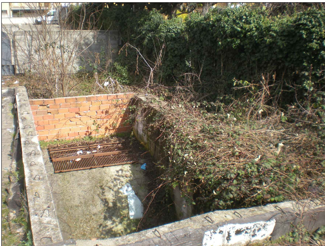
FOTO 21 - VISTA DELL'USCITA DI SICUREZZA DAL CORRIDOIO PERIMETRALE (ANGOLO NORD-EST)
