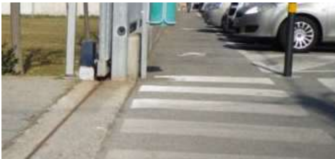
Consigliato posizionare nuova guida sopra quella esistente e rialzare l'accesso di almeno 10 cm visto che la strada e' soggetta a asfaltature ogni 20 anni . Evitare che acque ruscellanti lungo strada entrino nell'area depressa
