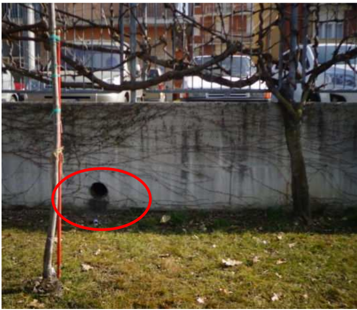
Particolare rilevato in terra e muro che testimoniano l'altezza del terreno riportato
