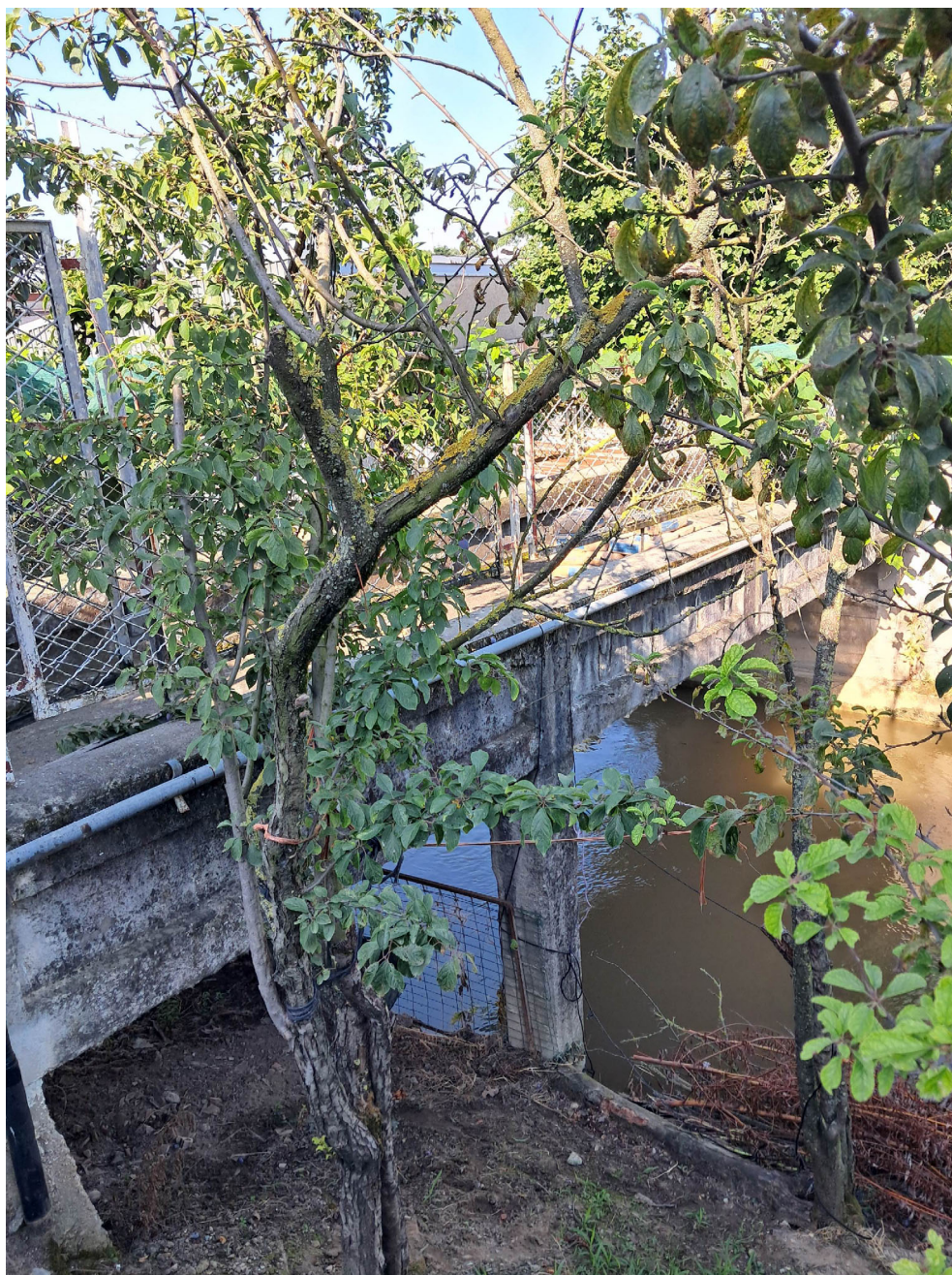
Immagine 5— ponte in via Torquato Tasso 30 a Fossano ponte scaricato
