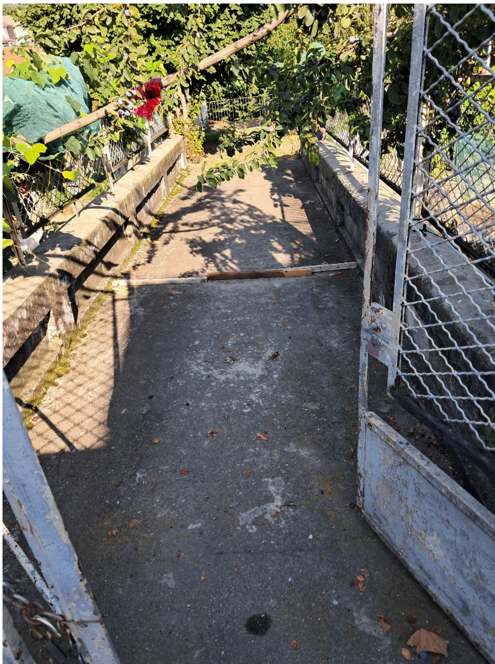
Immagine 2— ponte in via Torquato Tasso 30 a Fossano vista frontale
