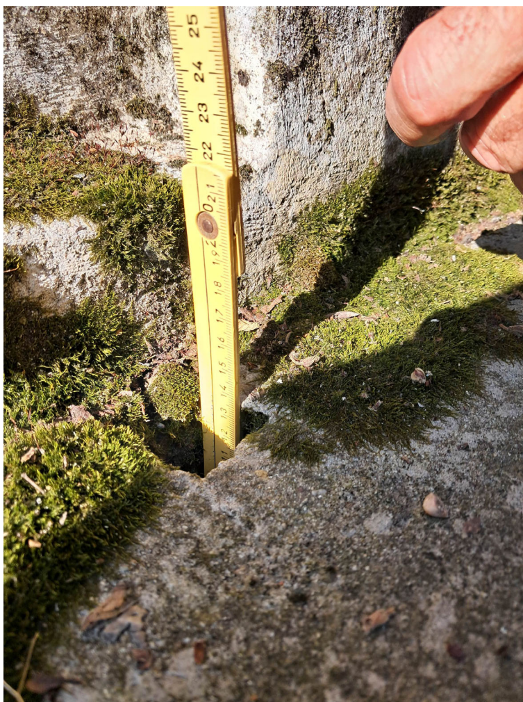
Immagine 3– ponte in via Torquato Tasso 30 a Fossano spessore soletta in c.a.o. armata caricata fino a 500 daN/mq
