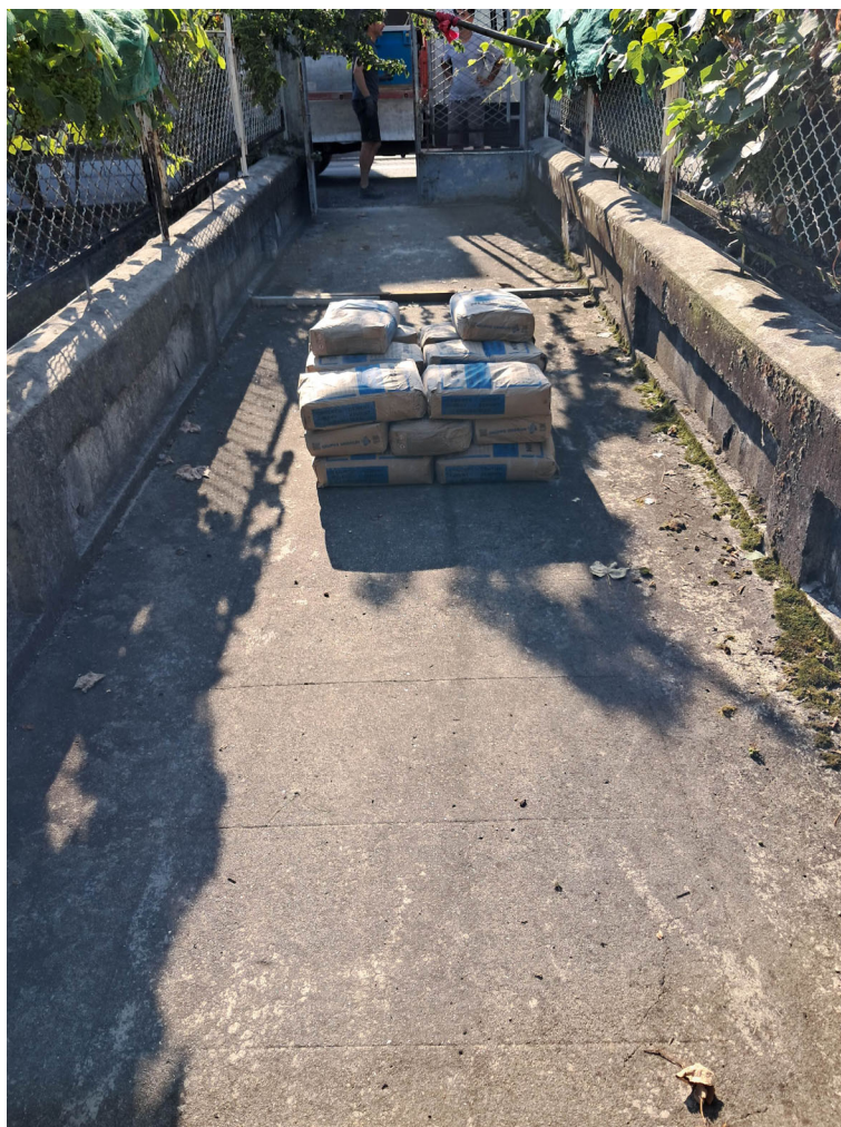
Immagine 4– ponte in via Torquato Tasso 30 a Fossano carico numero 20 sacchi di cemento peso di ognuno 25 kg distribuiti su un mq di superficie
