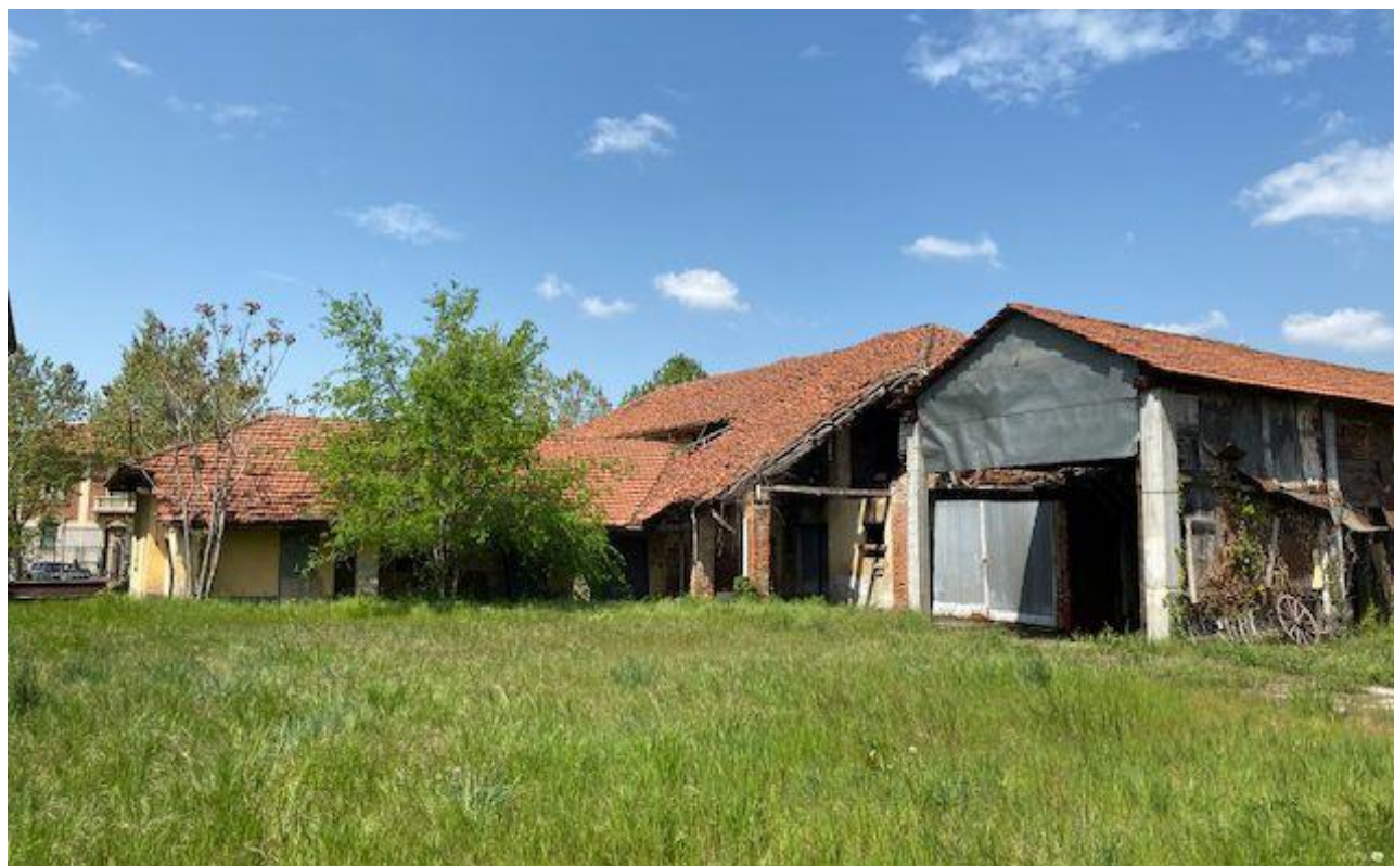
Viste dal cortile interno
