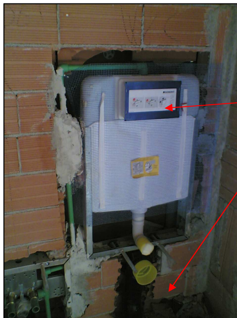
Figura 27 – modalità di posa ancoraggi tubazioni di scarico
