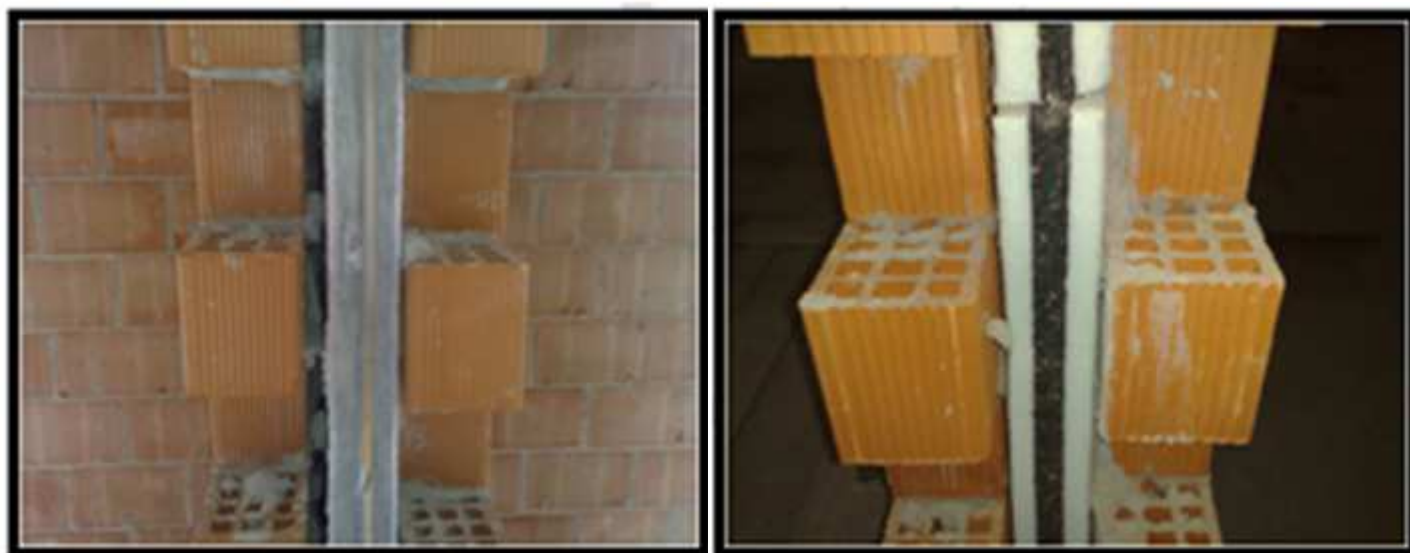
Figura 15 - modalità di posa a "effetto tenda" soluzione 1 e soluzione 2
