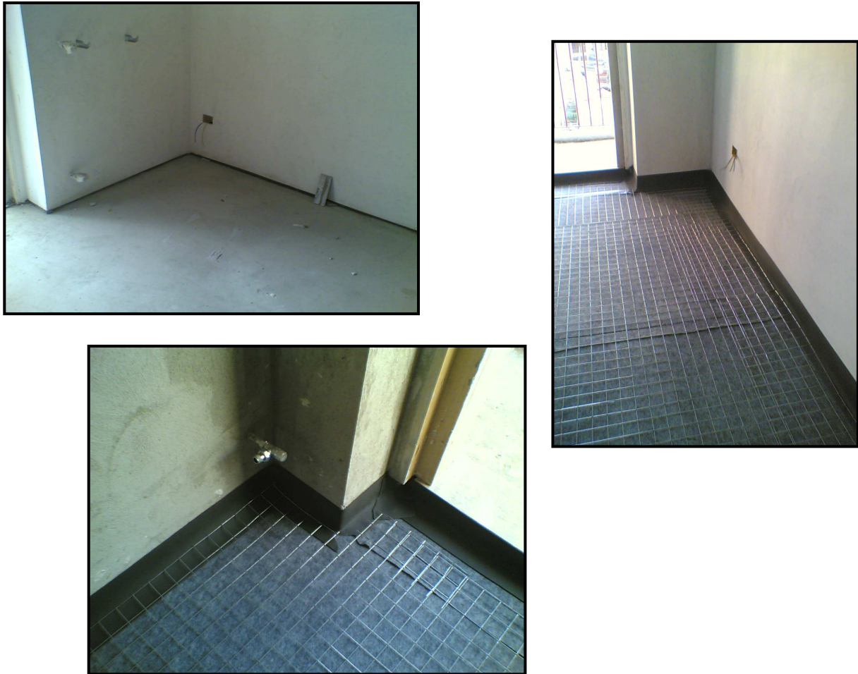
Figura 19 - posa del materiale in cantiere
