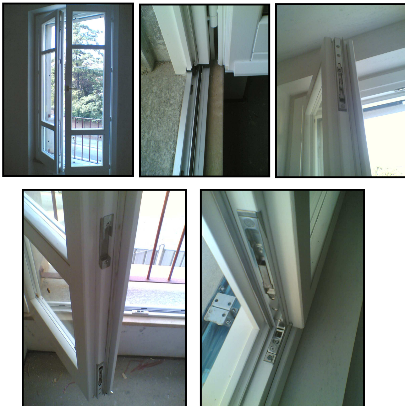
Figura 20 - serramento in legno lamellare con 6 punti di chiusura e 8 cerniere di tenuta
