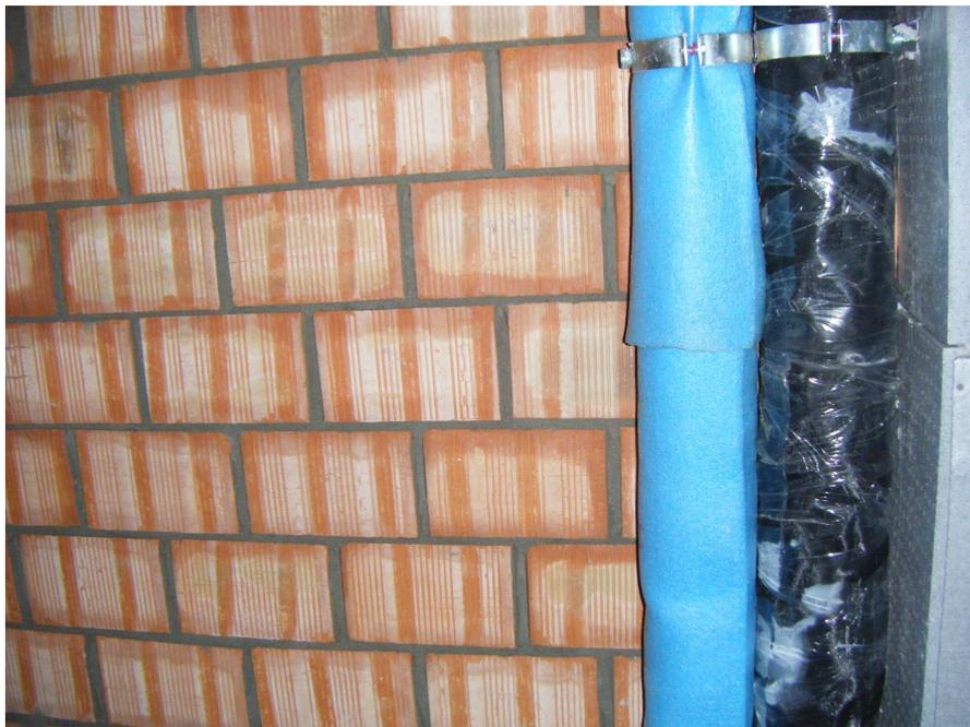
**Figura 25 – rappresentazione prodotto commerciale – COIBENTAZIONE IN OPERA (VENTILAZIONE BAGNI + SCARICO BAGNI)**
