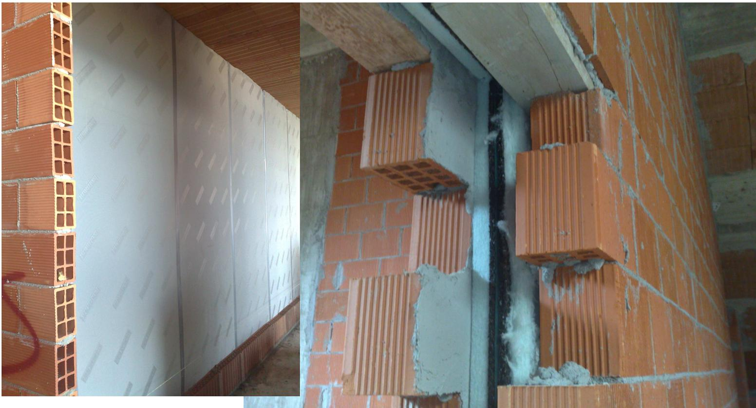
Figura 16 – potenziamento pareti di confine – piano terreno – piano primo
