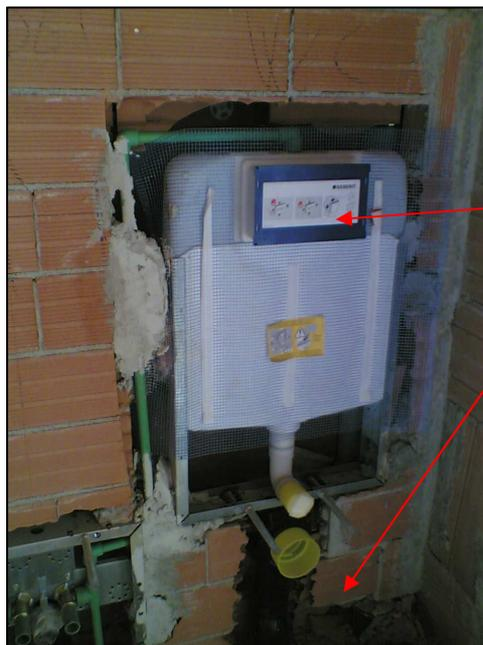
rivestimento integrale con lamina di piombo gommato da 0.35 mm – **se su confine con U.A.**
