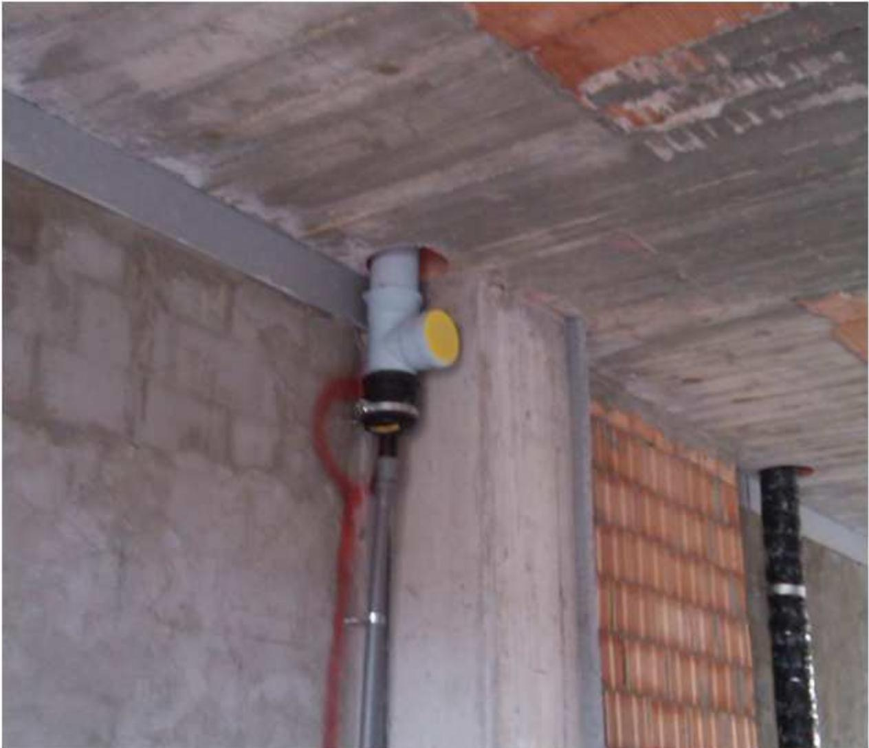
**Figura 24 - nel caso di possibilità di condensa sulle cappe si prescrive il tubo di scarico condensa - non sono necessarie coibentazioni acustiche**
