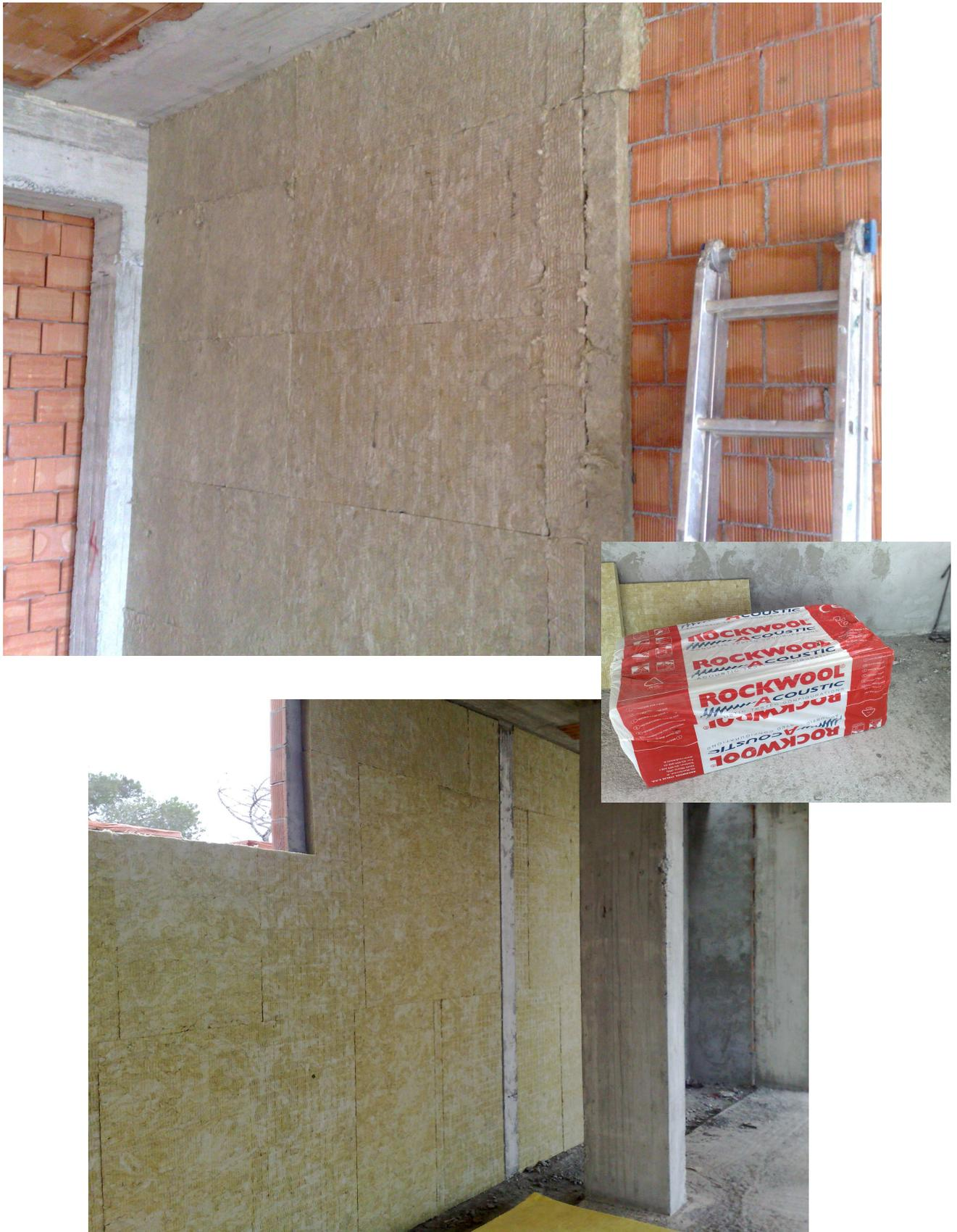
**Figura 11 - tamponamento parete esterna con lana di roccia - densità min. 60 kg - verifica termoigrometrica da parte del progettista termotecnico**
